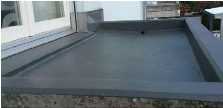
Wasserzwichenspeicherung auf einem Dach (Foto: K.PLAN)
